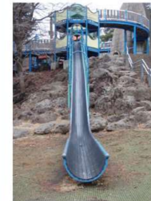
改修前(1994年竣工)
