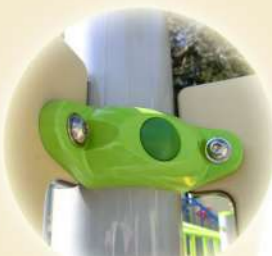
ボルト接合のため 部分補修が可能。
