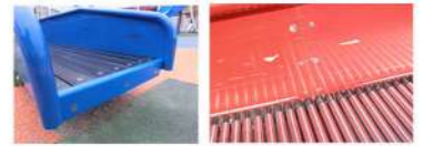
※汚れ・塗装はく離れたコの字型すべり台の側板
